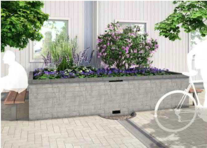
Exempel på upphöjt biofilter som tar emot dagvatten från tak via stuprör, med utlopp i botten och avledning via ränna. (Norconsult, 2022-03-14. Bildkälla Vinova, 2014)
