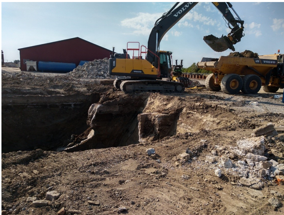
Delområde M1 schaktas ur, provtas och återfylls med rena massor.
